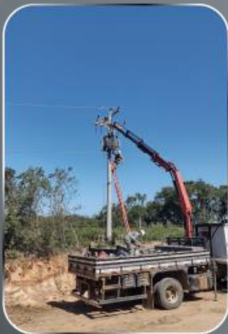
Instalação de Transformador
